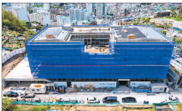
서구 구립 도서관 건립 공사
