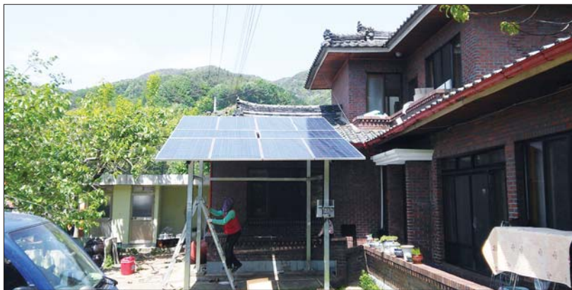
사진은 태양광발전설비가 설치된 한 주택의 모습.
